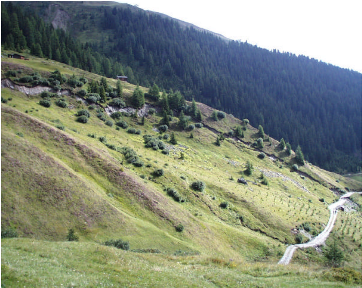
Foto 13: Sessladalm im Gemeindegebiet von Pfunds im Oberinntal: Eine ausgedehnte Scholle des Almgebietes droht im Frühsommer 1999 in den Sessladbach zu gleiten. Dadurch ist eine Gefährdung von Teilen Pfunds zu befürchten.
