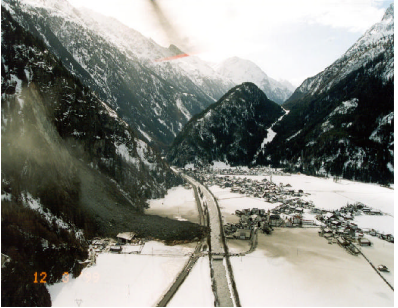
Foto 3: Bergsturz von Huben, Gemeinde Längenfeld/Ötztal am 11.03.2001: Etwa 200.000 m 3 Festgestein verschütteten den Großteil eines Sägewerkes und die Ötztal-Bundesstraße. Auch die Stromversorgung für die mit Fremden voll belegten Hotels der Gemeinde Sölden und die gesamten Lifтанlagen ist unterbrochen Die Staubfahne überzieht einen Großteil des Ortes. Es gilt für die Behörde (Bezirkshauptmannschaft Imst) und ihre Sachverständigen rasch zu entscheiden, in welcher Art weitere Gefahr drohen könnte, beziehungsweise ob mit der Wiederherstellung der Straßenverbindung und der Stromleitungen begonnen werden kann.
