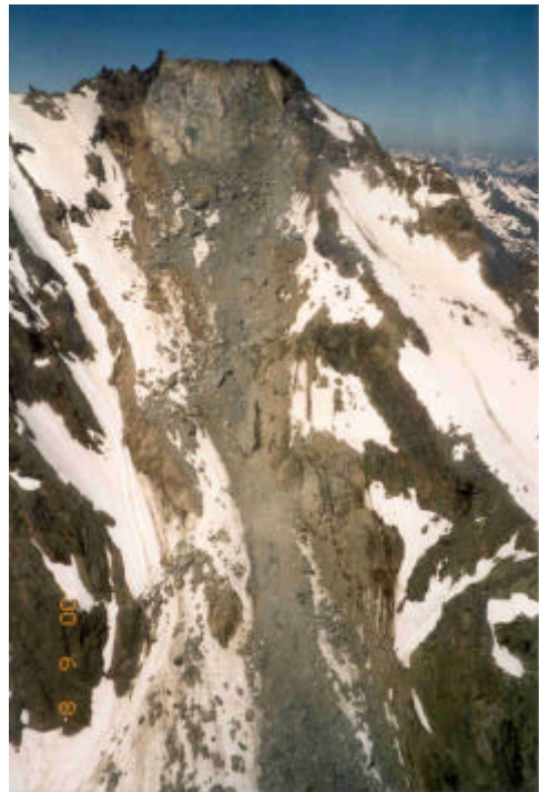
Foto 8: Bergsturzgebiet Luibiskogel im Sept. 2000. Der Wanderweg wurde verlegt und der alte Weg per Verordnung gesperrt.
